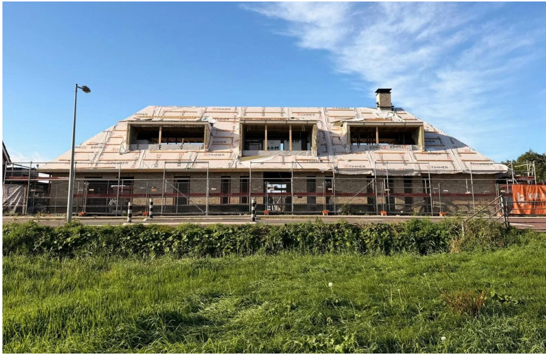
Inmiddels is de bouw zover gevorderd dat goed te zien is dat de nieuwe hoeve sterk lijkt op zijn voorganger. Foto: Hetty Kuijper-Worm.
