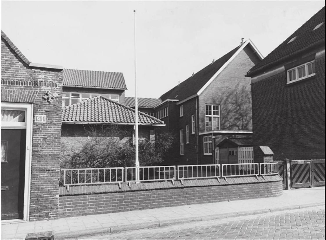
De entree van de Sint-Jozefschool, die werd gebouwd in 1913-1914, met aan weerszijden van de hoofdingang de oorspronkelijke hoge bebouwing. De nieuwbouw zal hierop lijken. Met links het lagere dak van het 'conferentiezaaltje' bij het Parochiehuis. Hiervan is op dit moment nog niet bekend welke partij met welk doel dit heeft aangeschaft. Foto: Beeldbank Stadsarchief Amsterdam, april 1969.
