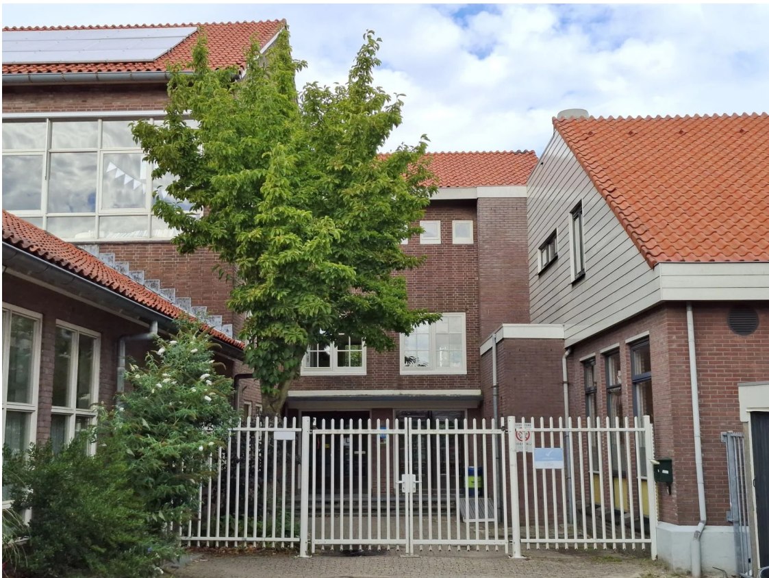
De huidige entree van SBO De Driesprong met aan de rechterzijde de verlaagde witte houten bovenverdieping uit 1991, die zal worden verwijderd en vervangen. Voormalig schoolhoofd van de Sint-Jozefschool Theo Durenkamp was ook toen al lid van de Werkgroep Publiciteit en schreef hierover in dat jaar een artikel in het Witte Weekblad waarin hij ook beknopt
