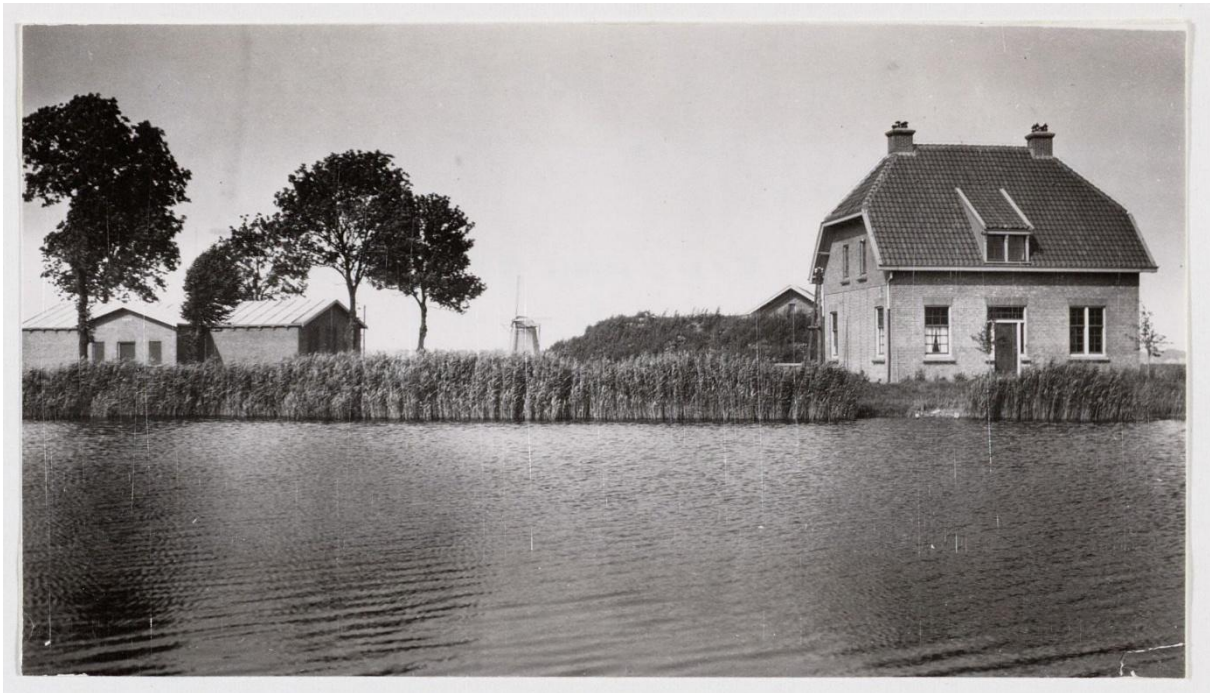
1922 zicht op de fortwachterswoning vanaf Ringvaart – foto J. van Eck – Beeldbank Amsterdam. Het pand links op de foto is nog aanwezig. Geheel rechts op de foto de fortwachterswoning. Linksachter daarvan zichtbaar het aangeaarde munitiedepot. Middenachter de Riekermolen (1636), die nu ten zuiden van het Amstelpark aan de Amstel staat.
