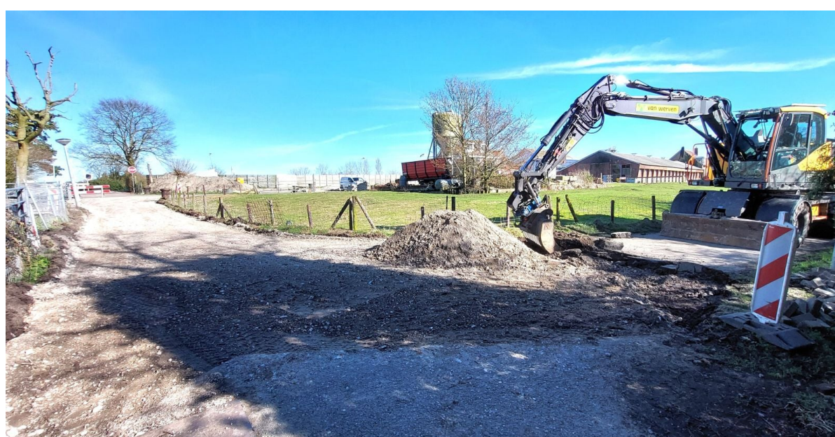
Op 2 maart is begonnen met de renovatie van de Onderweg. Het wegdek is inmiddels van zijn asfaltlaag ontdaan en krijgt vervolgens een puinfundering. Bij eerdere wegdekvervangingen van de Osdorperweg is deze weg – die op een lager niveau achterlangs de dorpskern van Oud Osdorp loopt – nog nooit gerenoveerd. Hierdoor verkeerde deze in een zeer slechte staat. Verwacht wordt dat eind maart ook dit deel van Oud Osdorp van een goed wegdek is voorzien. Foto: Theo Durenkamp.
