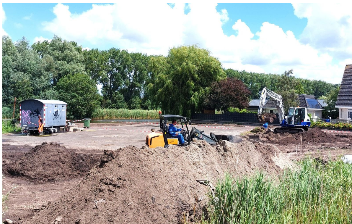
De grondwerkzaamheden op het 'Over de Rand'-terrein op de hoek Osdorperweg / Joris van den Berghweg zijn nu écht van start gegaan. Nog 'even' en dan zal hier eindelijk het speelterrein ingericht kunnen worden.
