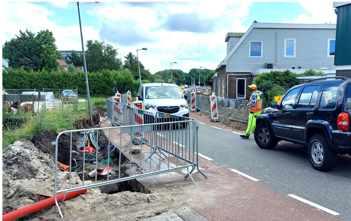
Fase 1 van de werkzaamheden aan de Osdorperweg in Oud Osdorp is in volle gang: Liander vervangt elektriciteitskabels. Foto: Theo Durenkamp.
