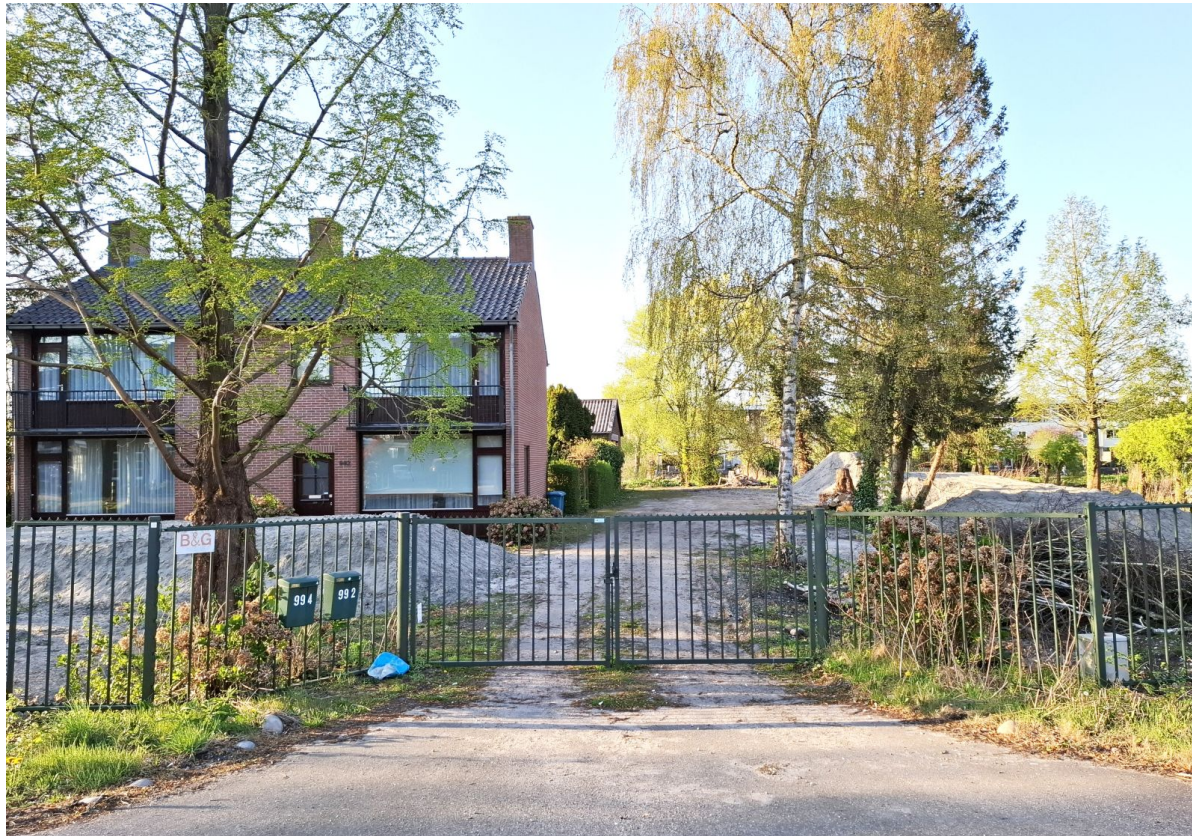
De huidige situatie gezien vanaf de Sloterweg met links Sloterweg 994 en midden huisnummer 992. De zandhopen rechts en voor laten de ondergrond alvast inklinken. Dat is noodzakelijk om hier te kunnen bouwen.
