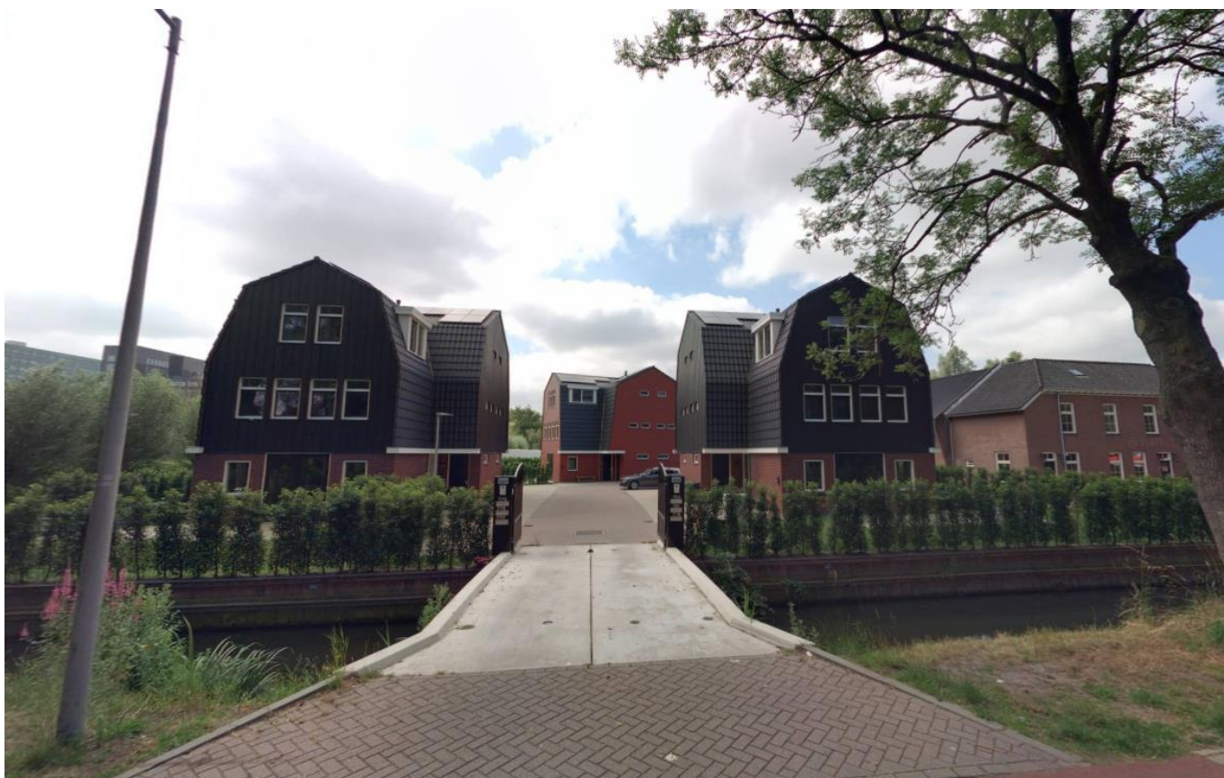
Figuur 2-1 – Vooraanzicht Sloterweg 779 te Amsterdam, bekeken richting met zuiden vanaf de Sloterweg (bron: Street Smart, Juni 2024).
