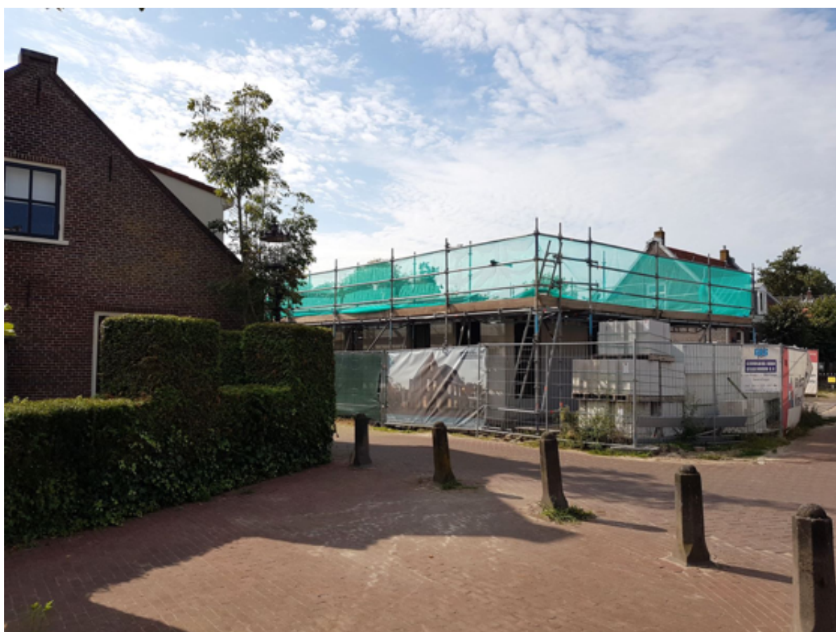
Een tussentijdse foto van de bouwactiviteiten in het hart van Sloten waar voorheen garage Kuykhoven was gevestigd. De muren van de begane grond van 7 van de 8 woningen staan inmiddels overeind en de contouren van de eerste 1,5 verdieping worden zichtbaar. Met dit beeld kunnen lezers van deze Nieuwsbrief die minder vaak op het dorp komen alvast een beetje wennen aan het veranderende aanzicht. Hier komt straks nog 1,5 woonlaag bovenop.
