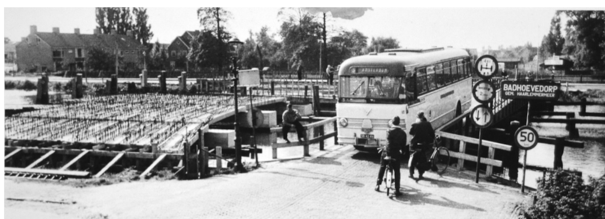
De eerste Sloterbrug, de draaibrug, gezien van Sloten naar Badhoevedorp, met een passerende bus van Maarse & Kroon. Links is de nieuwe brug in aanbouw. Rechts naast de brug het plaatsnaambord 'Badhoevedorp'; 1962. Foto: Beeldbank Stadsarchief Amsterdam.
