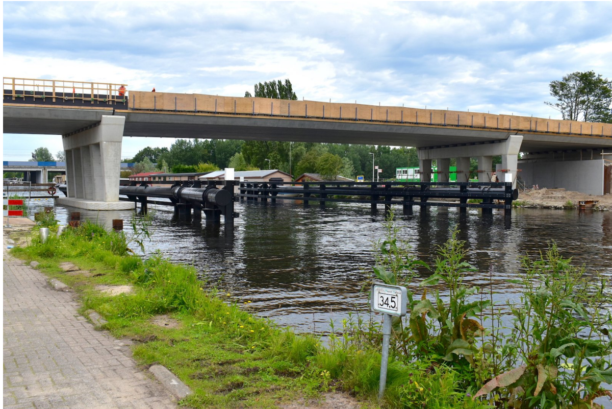
De werkzaamheden om de Oude Haagsewegbrug over de Ringvaart te vervangen vorderen gestaag. Alle overspanningen over de Ringvaart liggen inmiddels op hun plaats. Er is nu dus weer sprake van een brug. De komende maanden wordt deze verder afgewerkt. Foto: Erik Swierstra.
