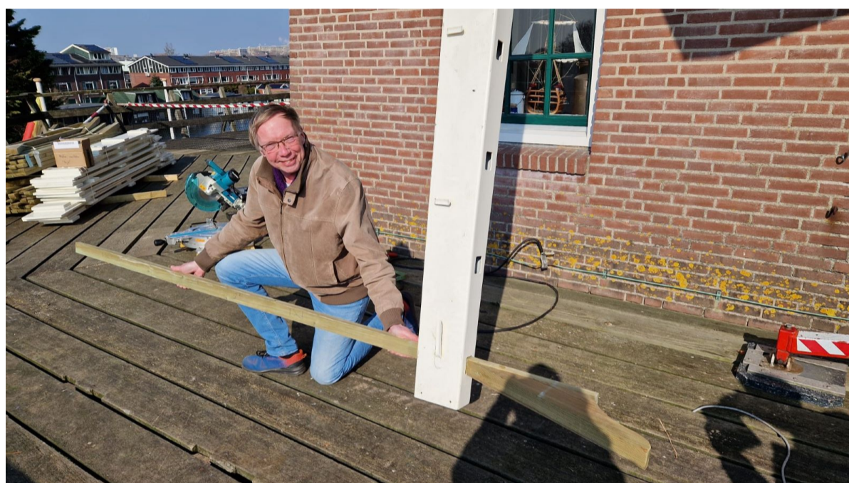
Aan de kersverse - net voor zijn molenaarsdiploma geslaagde - molenaar Theo Ijpmā de taak om de allereerste heklat in de nieuwe roede aan te brengen. Naar verwachting neemt het ophekken van de nieuwe roeden ongeveer twee weken in beslag. Daarna kan de molen weer veilig en met volwaardige wieken zijn rondjes draaien. Slotense molenaars zullen molenmaker Poland - die destijds verantwoordelijk was voor de bouw van de Molen van Sloten - hierbij waar mogelijk ondersteunen.
