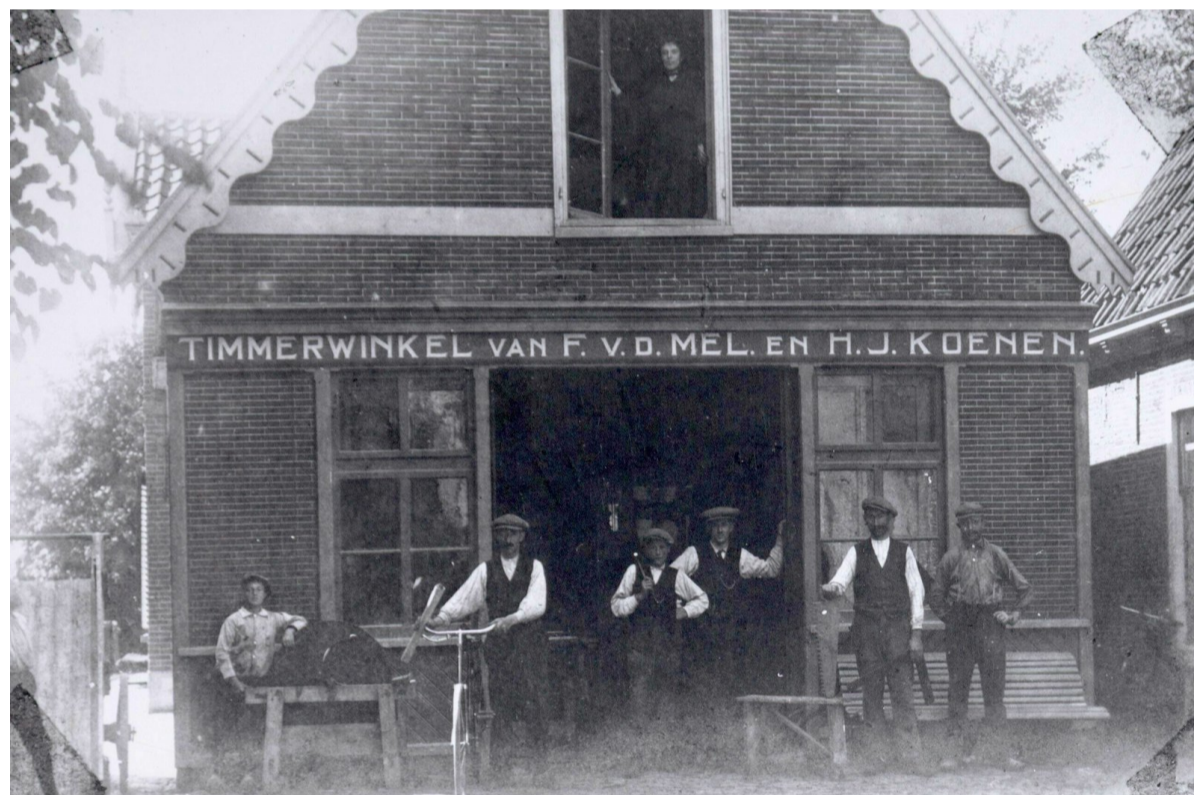
Timmerwinkel van F. v.d. Mel en H.J. Koenen; circa 1910. Foto: Beeldbank Stadsarchief Amsterdam.
