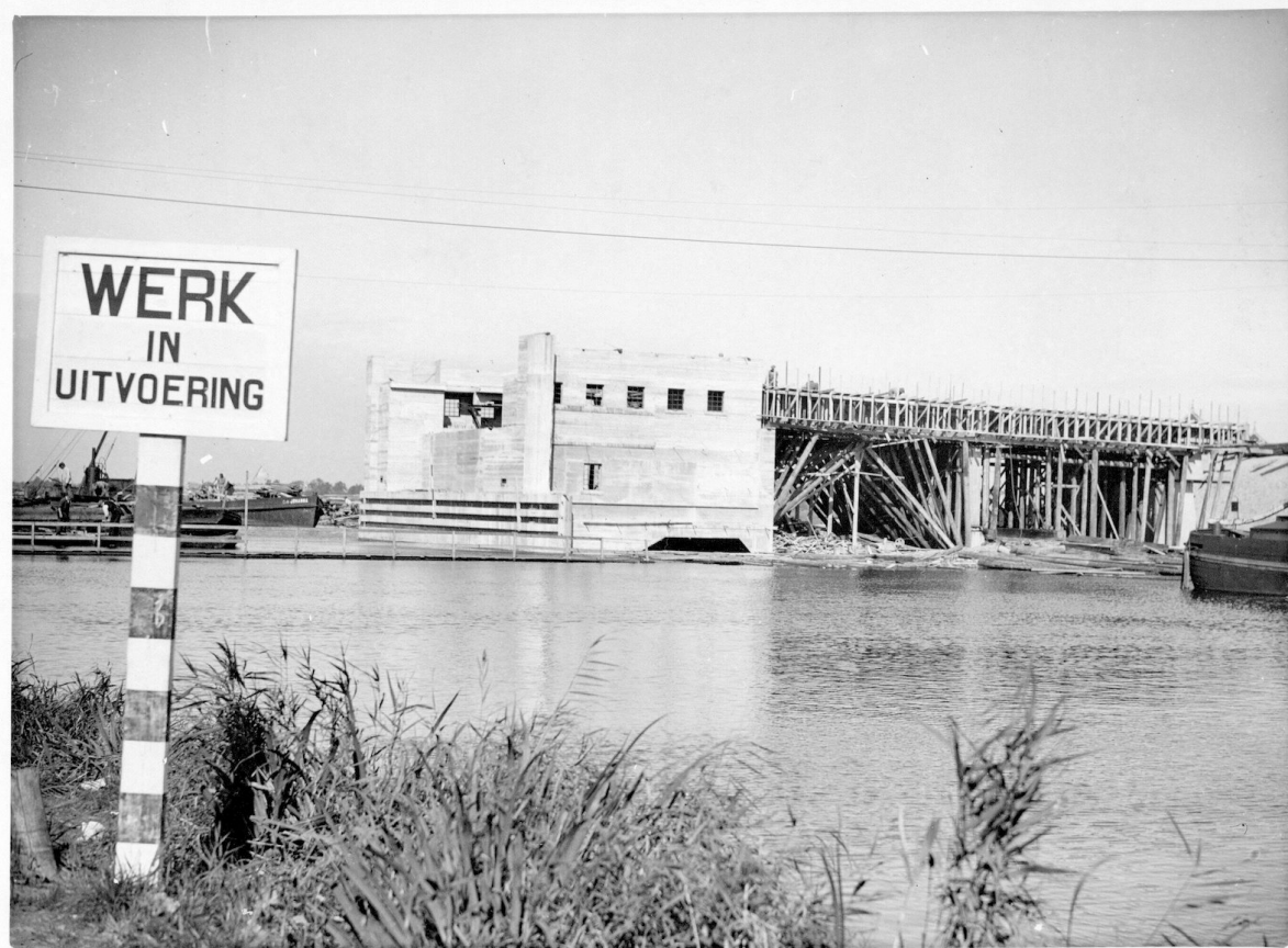
De brug over de Ringvaart in Rijksweg 4 van Sloten naar Den Haag in aanbouw; 1 oktober 1934. Foto: Beeldbank Stadsarchief Amsterdam.
