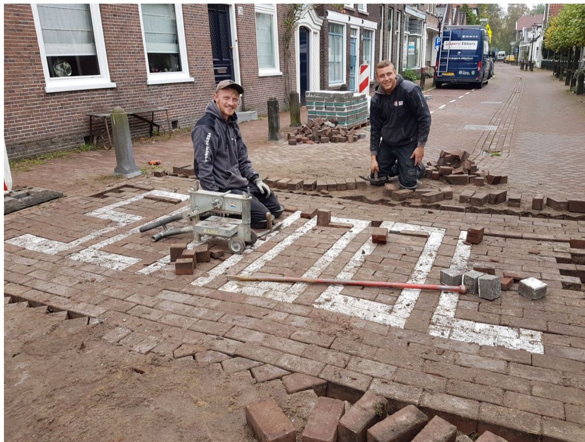
Op 26 en 27 oktober was het doorgaand verkeer in de dorpskern van Sloten gestremd om aan weerszijden van het dorp de tekst "SCHOOL" in te straten. Jesse van Varto uit Hoorn en Silvio Kroes uit Zwaag waren voor deze klus door de gemeente ingehuurd en leverden vakwerk. Het gebied tussen beide markeringen is nu een 'schoolzone'.
