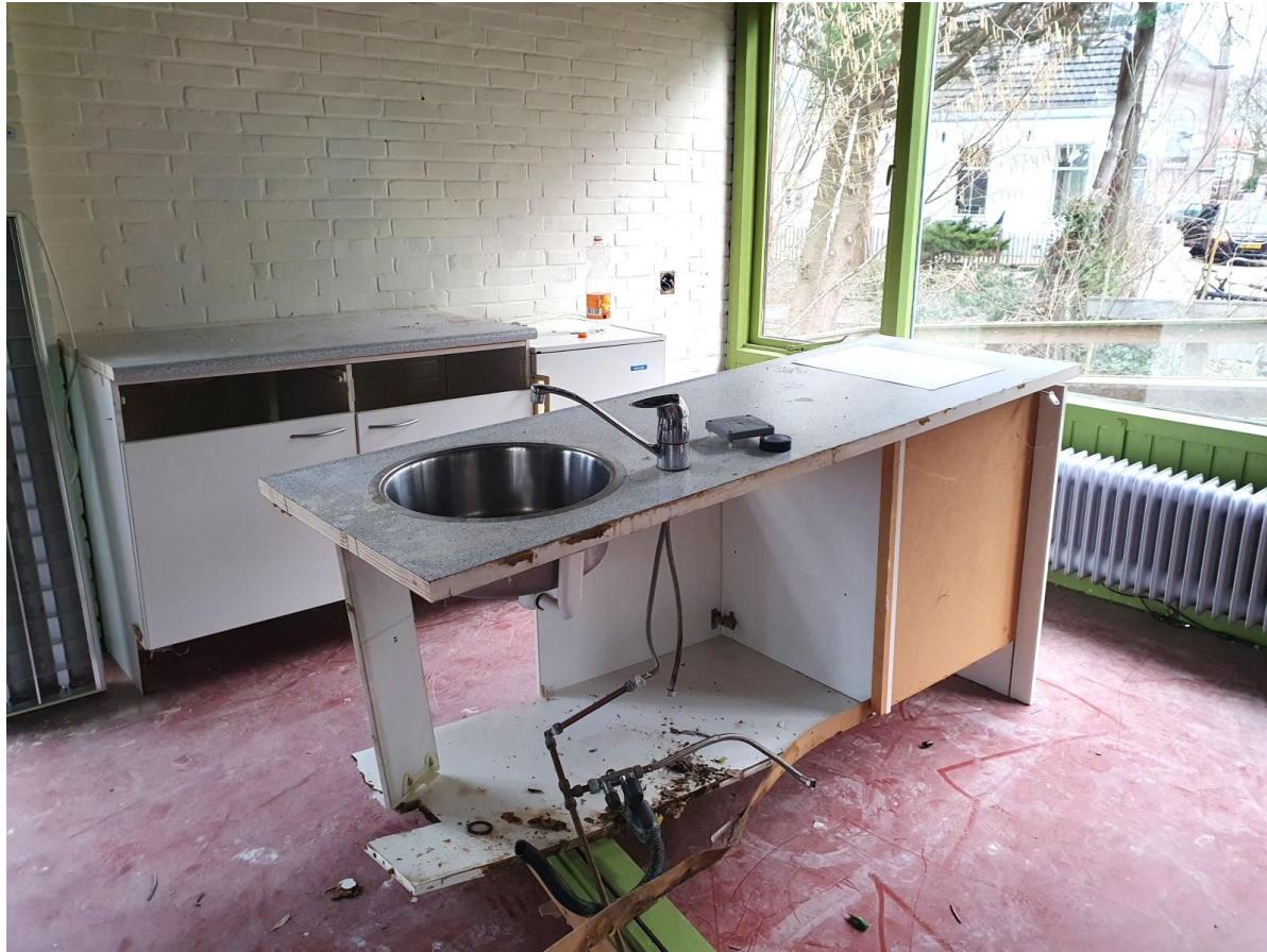
In de hoek waar tot voor kort het kantoortje was ingericht, komt straks de keuken. Op die manier wordt de ruimte in het Dorpshuis efficiënt benut. Foto: Petra Clement.
