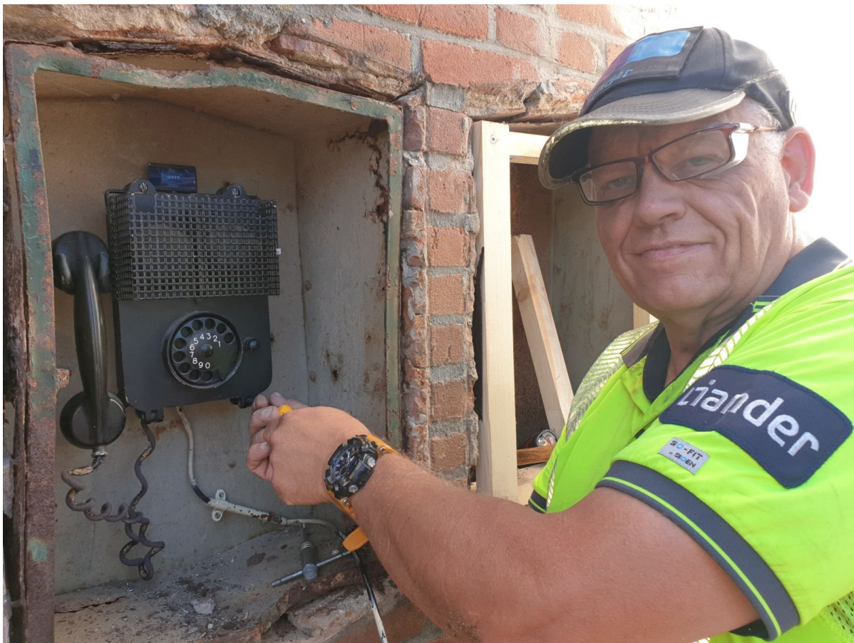
Hoofdmonteur en leermeester Rob Teffer van Liander plaatst de oude telefoon in de linker GEB-kast aan de Sloterweg. Foto: Guido Frankfurter.
