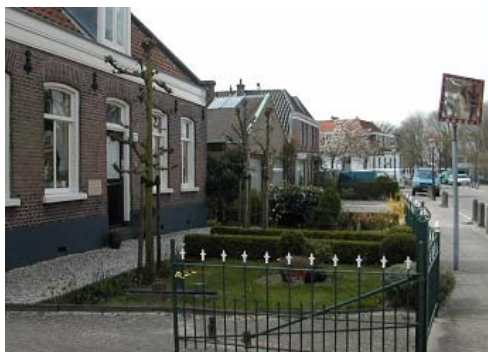
Voortuinen met erfafscheiding aan de Sloterweg; daarachter is de tuin verhard als parkeerplaats
