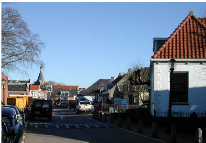
Sloterweg aan de rand van de kern; vrijstaande bebouwing
