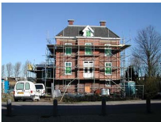
Nieuwbouw "Herenhuys" aan de Osdorperweg
