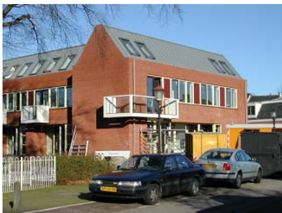
Nieuwbouw op de hoek Sloterweg-Akerpoldersloot
