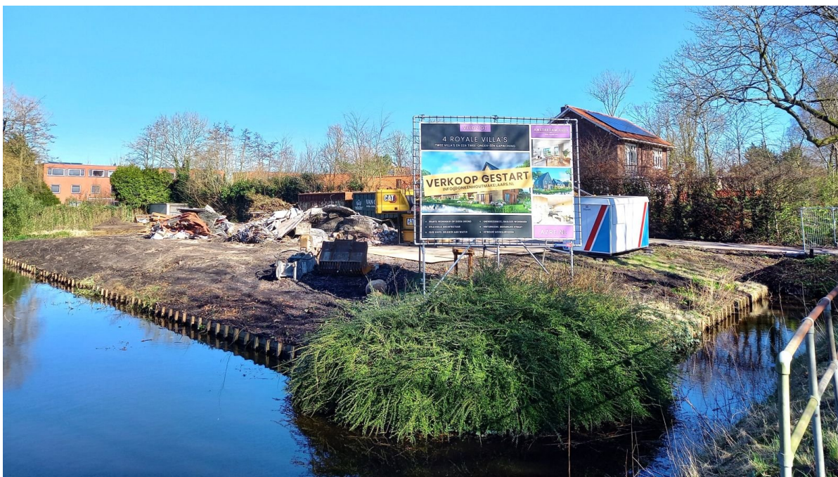
Eind februari werd de vrijstaande villa aan de Sloteweg 842 gesloopt. Hier zullen vier villa's van ieder € 1,5 miljoen worden gebouwd. Foto: Piet Renooy.
