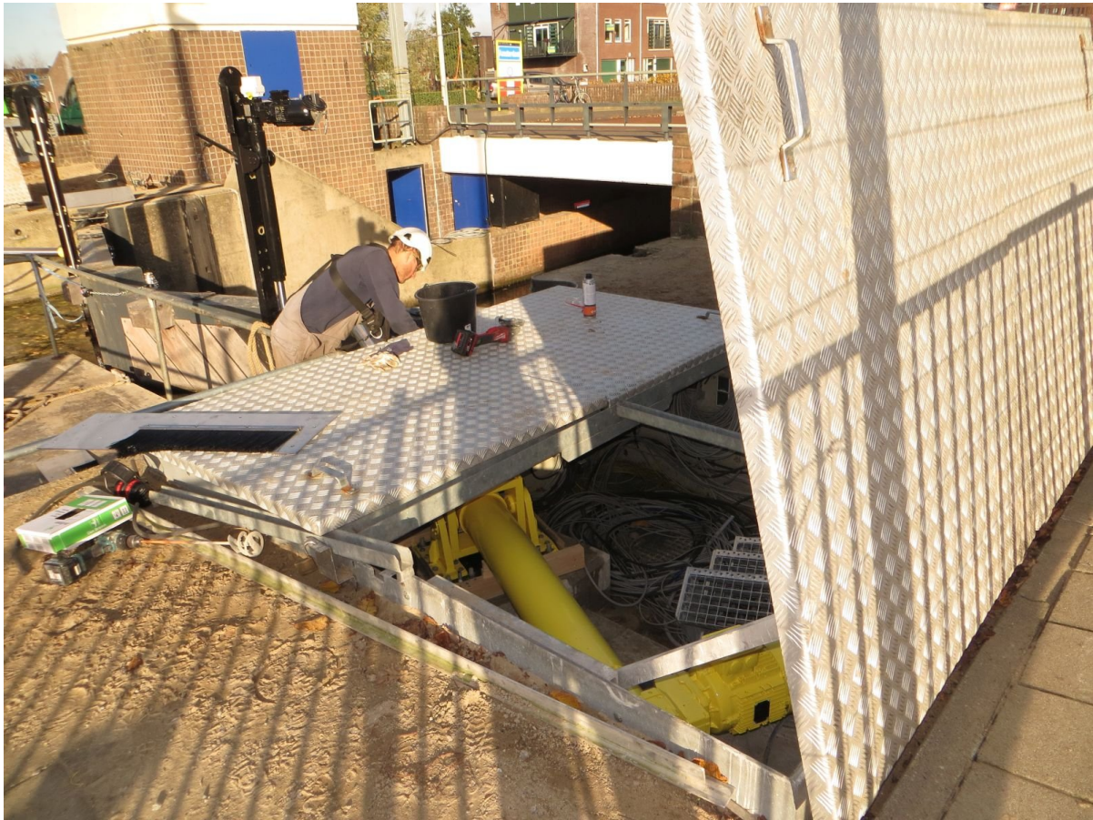
Inkijkje in een kelder van de Akersluis.
