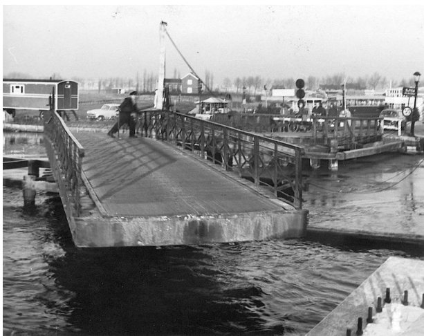
De oude draaibrug tussen Badhoevedorp en Sloten in 1962. De draaibrug werd in beweging gebracht door een sleutel die in een rondsel in werking bracht. Foto: Noord-Hollands Archief.
