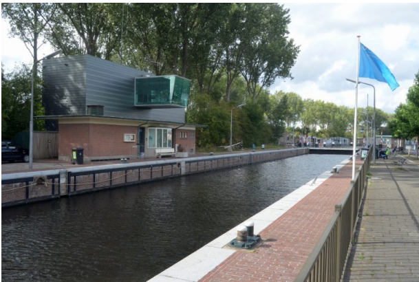
De Nieuwe Meersluis met oude en moderne bedieningspost. Foto: Erik Swierstra; 22 augustus 2020.
