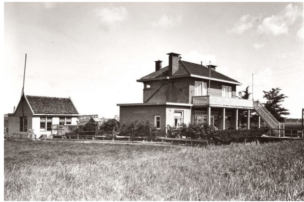
Het nieuwe gebouw uit 1937 van Café 'Meerzicht' gezien in zuidelijke richting naar de Nieuwe Meer; jaren dertig. Foto: Beeldbank Stadsarchief Amsterdam.
