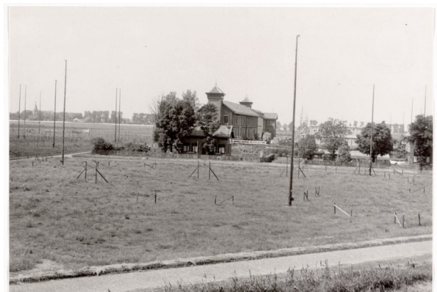
De bronwaterleiding gezien van de (Oude) Haagse weg in 1953. Het gebouw met de twee torens is de ontijzeringsinrichting uit 1902.
