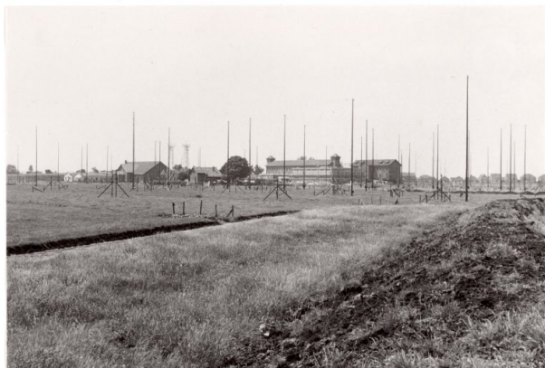
De bronwaterleiding naar de Ringvaart en de oude Haagseweg in 1953. Links van beide ontijzeringsinrichtingen met de nieuwbouw bevindt zich de andere stokerswoning. Het grote gebouw links daarvan is het machinegebouw uit 1903. Door de twee zendtorens heen is nog juist de machinistenwoning te zien. De anten-nemasten zijn van de Rijks Luchtvaart Dienst. Foto: Beeldbank Stadsarchief Amsterdam.
