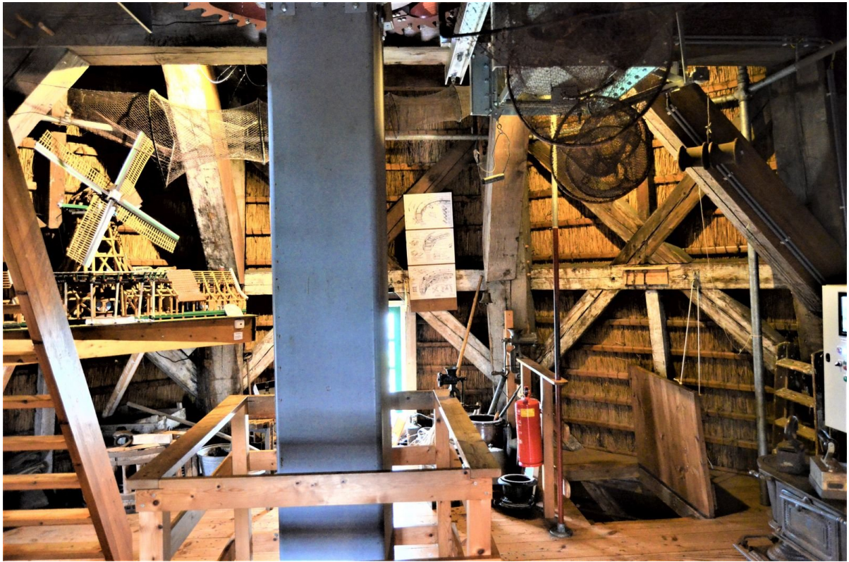
Een van de straks monumentale molenzolders met originele balken uit 1847. Foto: Erik Swierstra.
