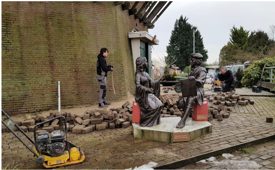
Op donderdag 18 februari 2021 rondten de stratenmakers hun werkzaamheden buiten af.
