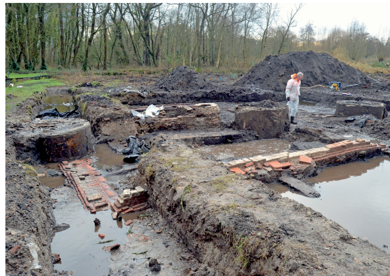
Leuk detail: De fundering van de waarschijnlijk 17de-eeuwse stal van de herberg staat op dakpannen. Goedkoop bouwen met wat voorhanden was... (Foto: Erik Swierstra)
