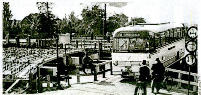
De rolbrug werd in beweging gebracht door een sleutel die een rondsel in werking bracht..
