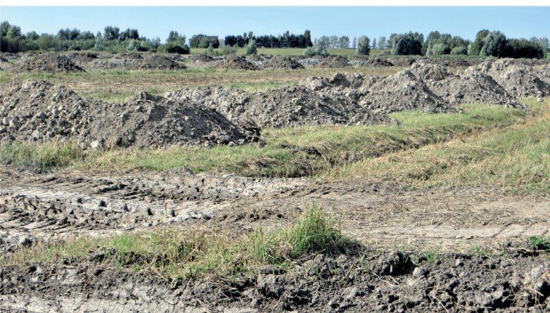
Fase 1 van de destructie van de Lutkemeerpolder, toen er nog geen zand gestort was.
