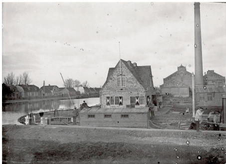
Gemaal en sluis Osdorper Binnenpolder; 1920.
