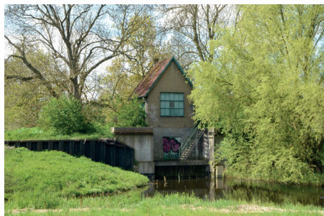
Gemaal van de Eendrachtspolder.
